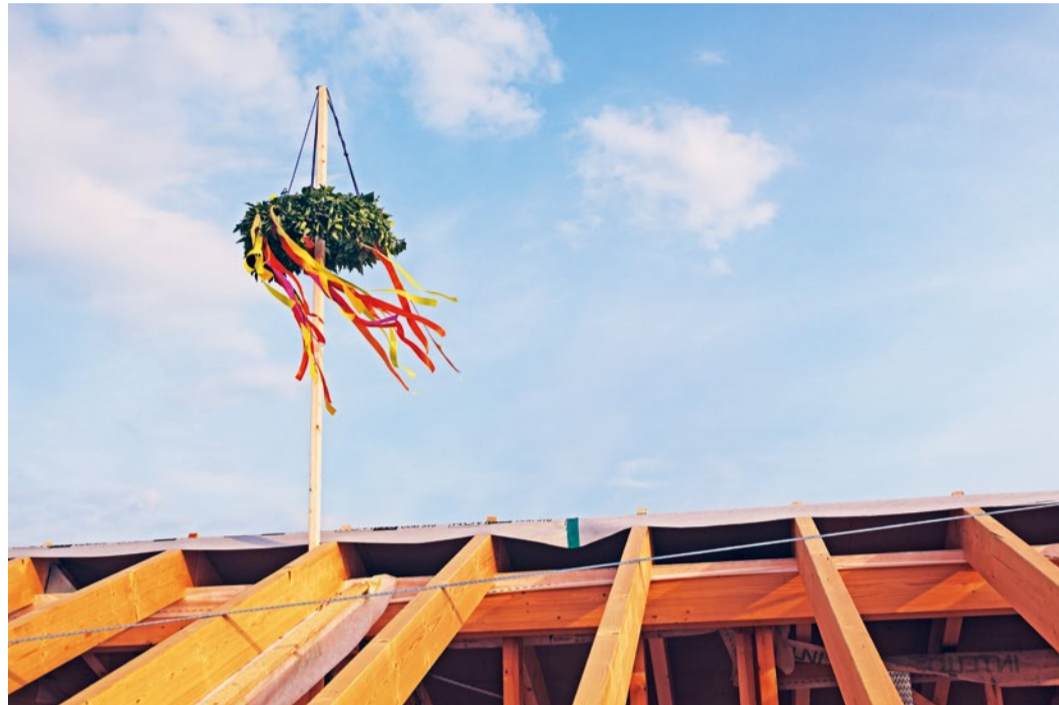
Bis der Richtkranz auf dem Gebäude steht, können manchmal Jahre vergehen. Foto: AdobeStock/Ingo Bartussek
